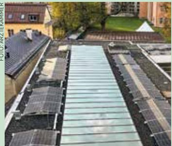
Photovoltaikanlage auszustatten. Nun wurde auf einer Fläche von 184,46 Quadratmetern eine PV-Anlage mit 100 Modulen errichtet, die eine Leistung von 38 kWp erzielt. Die erzeugte Energie wird im Kammeramt verbraucht. Mit 8. November 2022 ging die Anlage in Betrieb.
